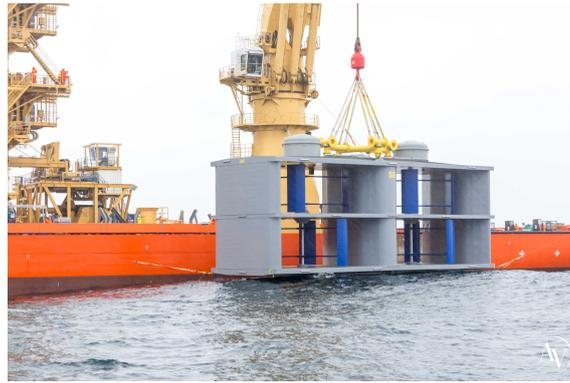
FIGURE 1 – Hydrolienne Hydroquest/CMN en cours d'installation sur le site de Paimpol-Bréhat (Bretagne, France).
